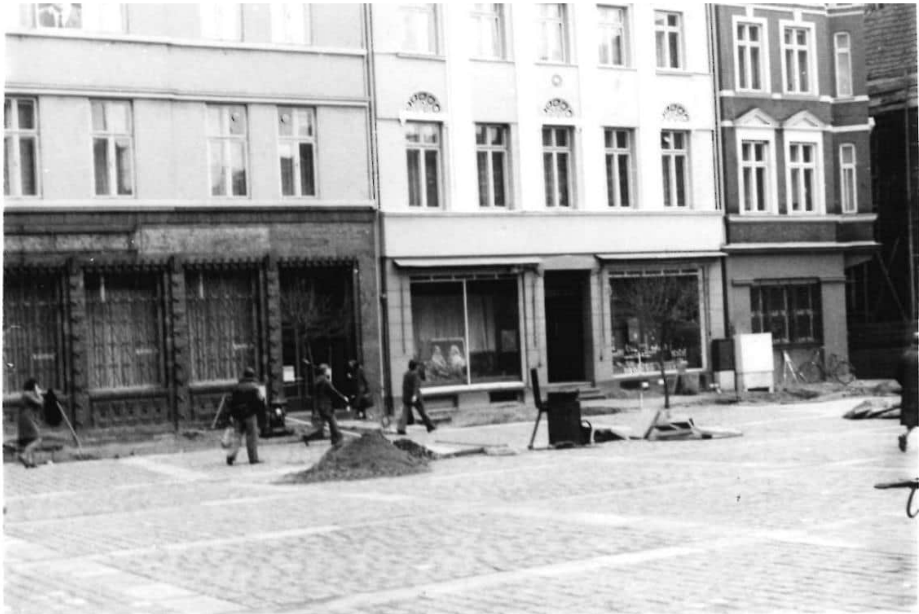
Markt Neubau des Brunnens 1978
