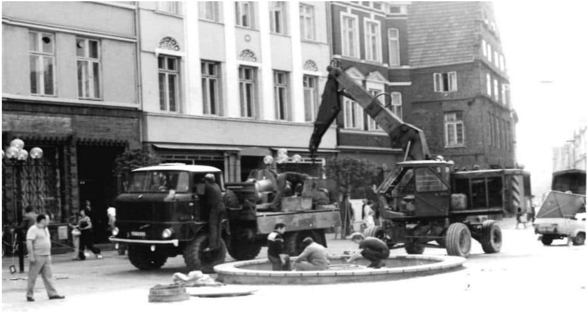
Markt Neubau des Brunnens 1978
